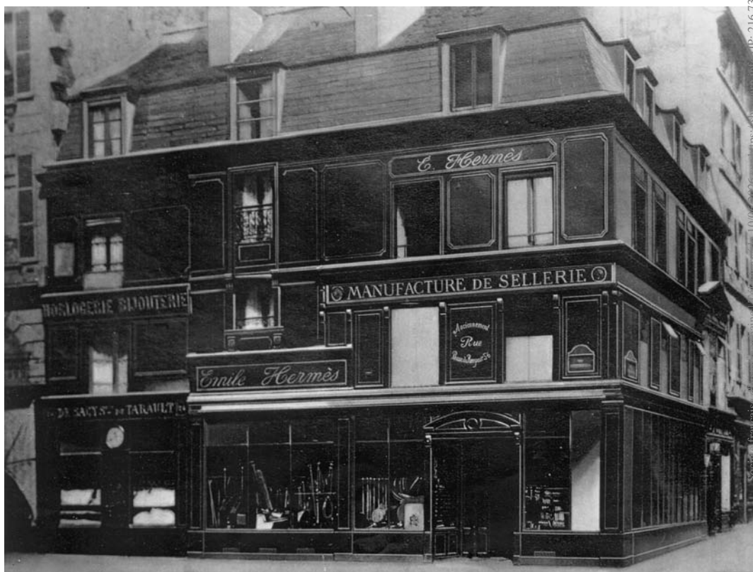
Figure 1 : Le 24 Faubourg Saint-Honoré rassemble dès la seconde génération : magasin, bureau directorial (au premier étage) et l'atelier de sellerie sous les toits.
