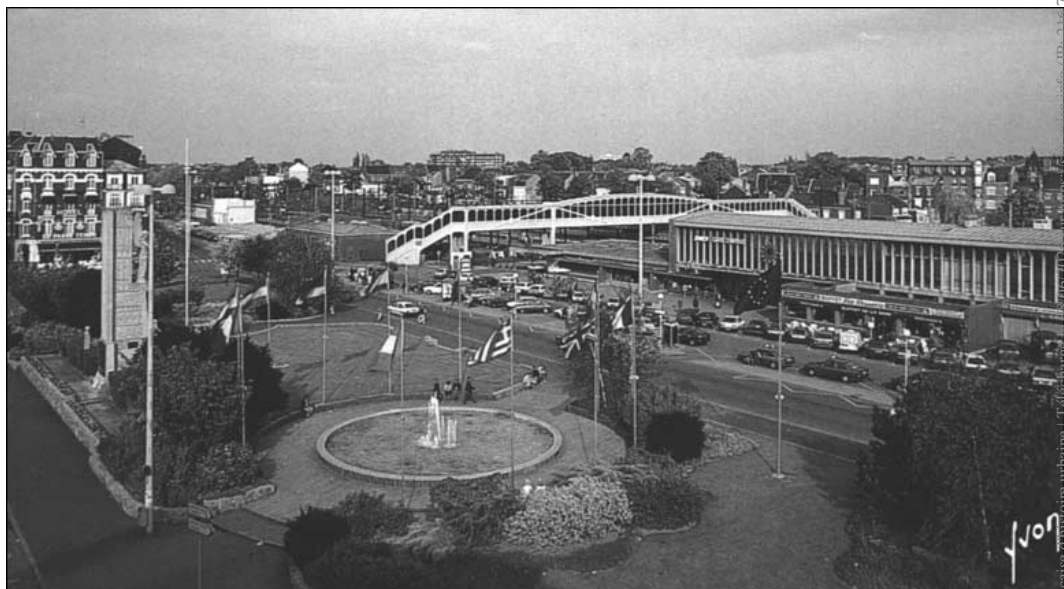
Fig. 5 : La gare reconstruite en 1957 avec à l'arrière-plan la passerelle de 1924.
