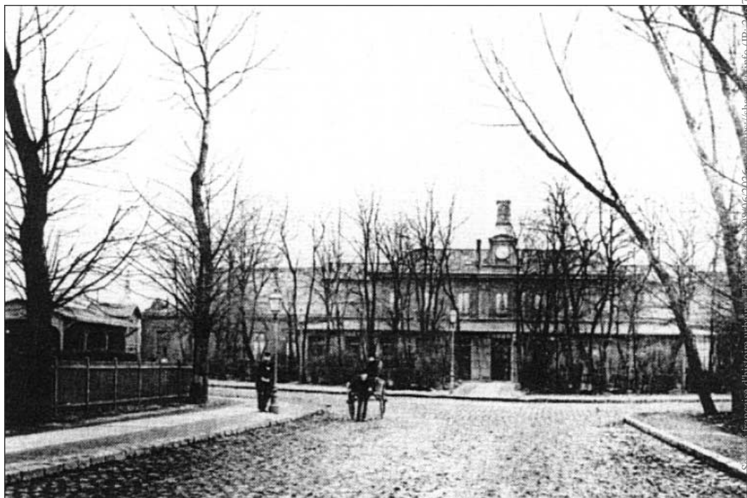
Fig. 2 : Photo de la façade de la gare de 1846.
