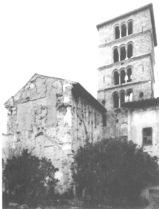
3. Farfa, vue extérieure de l'avant-nef, chœur carré et tour-clocher
