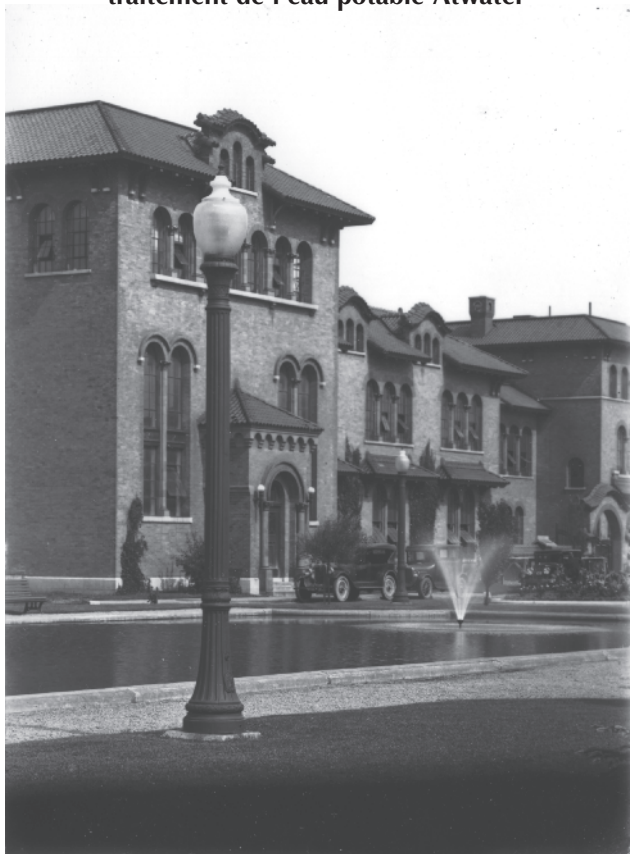
La construction de l'usine Atwater nécessite des efforts considérables et ses concepteurs, dont Georges Janin, comptent bien donner à ses bâtiments une signature architecturale digne de mention. Source: Ville de Montréal – Gestion de documents et archives, Photographies anciennes, Série Z, VM94-Z58-1, [193-]
