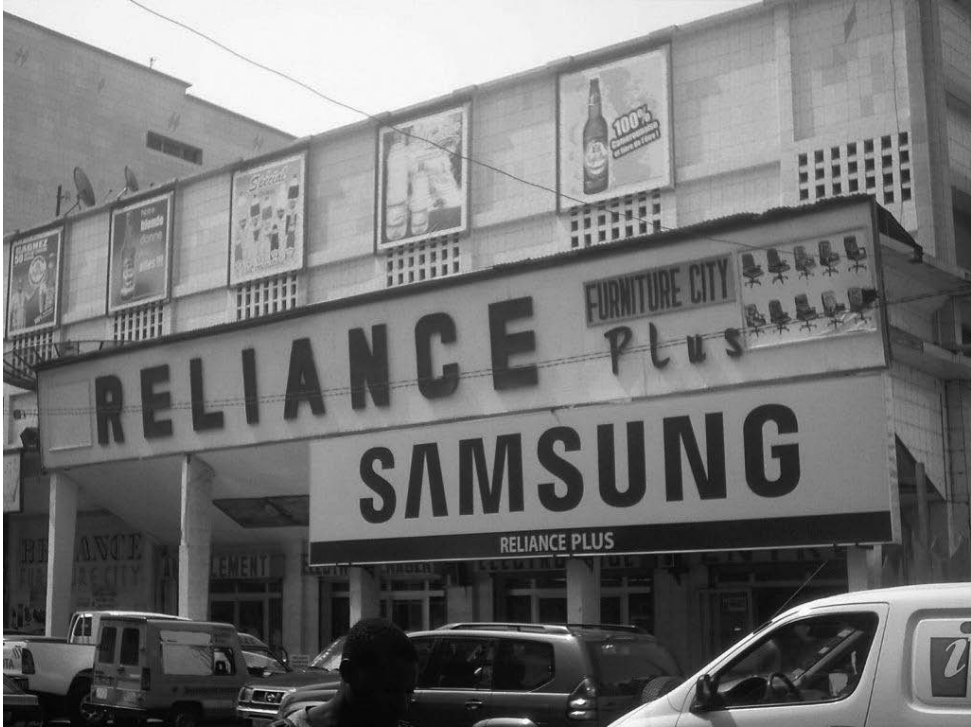
Le Capitole, reconversion d'un cinéma à Yaoundé. Fermé en 2003, l'ancien cinéma Le Capitole (Cameroun) est devenu un magasin d'ameublement, d'électroménager et d'électronique. Les encarts publicitaires ont remplacé les affiches de film. De l'extérieur plus aucun signe ne rappelle le passé culturel de ce lieu. Photo de Stéphanie Dongmo. Yaoundé, 17 janvier 2011.
