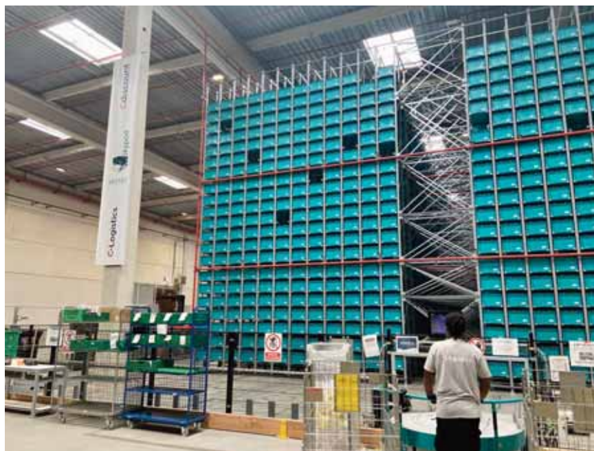
Installation des Skypods d'Exotec dans les entrepôts de Réau
